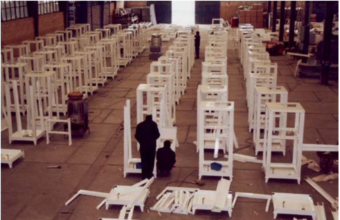
ساخت ۳۰۰ دستگاه زنت - پروژه آپارتمان‌های مسکونی نیرو دریایی
